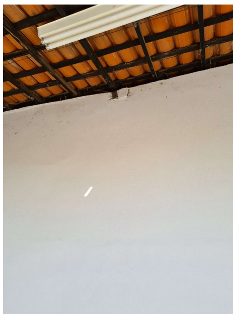
Figura 17 – Apoio das tesouras
