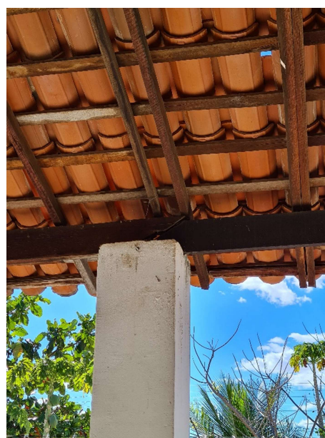
Figura 13 – Afastamento das sambladuras
