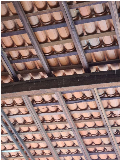
Figura 18 – Fissuras em terça
