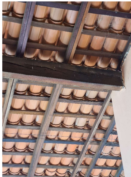
Figura 19 – Fissuras em terça
