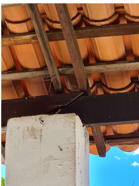
Figura 12 – Afastamento das sambladuras
