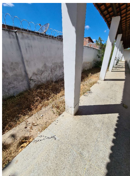
Figura 07 – Fissura de Pilar
